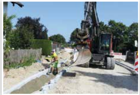
Derzeit erfolgt der Einbau der Bordsteine als Randeinfassung
