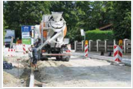
Zum Einbau der Bordsteine wird Beton benötigt
