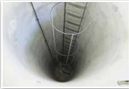
Ein Blick in den rund 8 m tiefen Schacht des Samer-Brunnens
