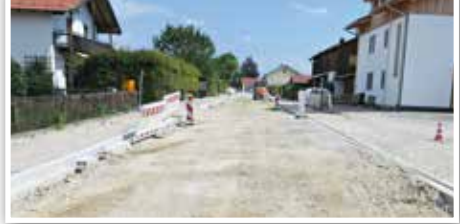
Der Bauabschnitt 2 der Bruckmühler Straße umfasst 700 m
