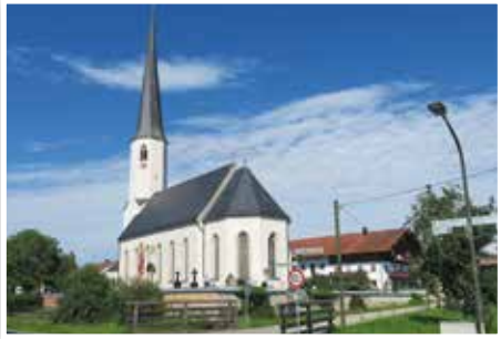
Die Kirchdorfer Kirche St. Vigilius wird einer umfassenden Innenrenovierung unterzogen
